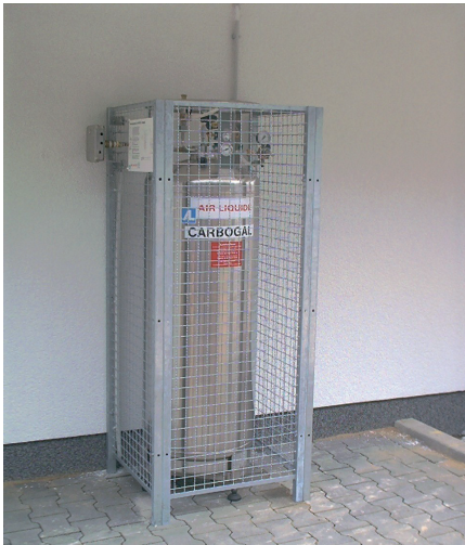
Abb. 14: Druckbehälter für CO 2 mit Schutzkäfig
