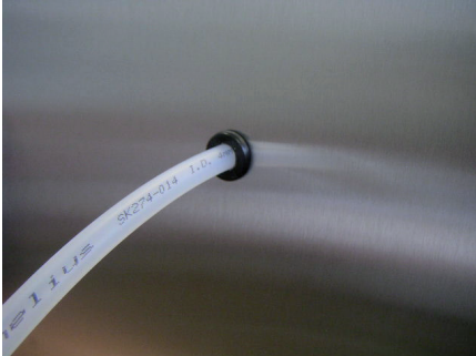
Abb. 7: Geschützte Verlegung der Gasleitung
